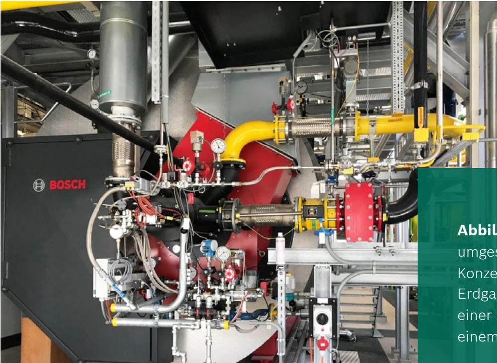
**Abbildung 2:** Beispiel eines umgesetzten Brennstoff-Konzepts mit Wasserstoff, Erdgas und leichtem Heizöl an einer Bosch-Kesselanlage bei einem Pharmaunternehmen.
